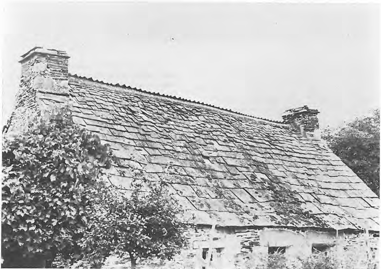
Toit traditionnel en grandes ardoises à Saint Ygeaux
